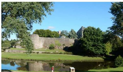
Quinze mètres de large pour une centaine de mètres de long, la digue de Montaigu est un ouvrage défensif monumental. Côté étang, la maçonnerie est composée de pierres en granit, taillées et régulières pour éviter les infiltrations. Côté Maine, la digue était ouverte de canonnières accessibles par une galerie interne descendant
